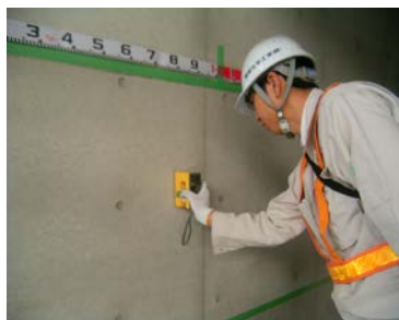
下地面の含水率確認
