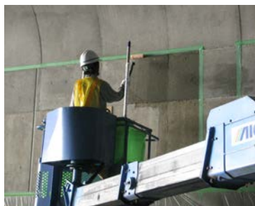
ローラー施工
